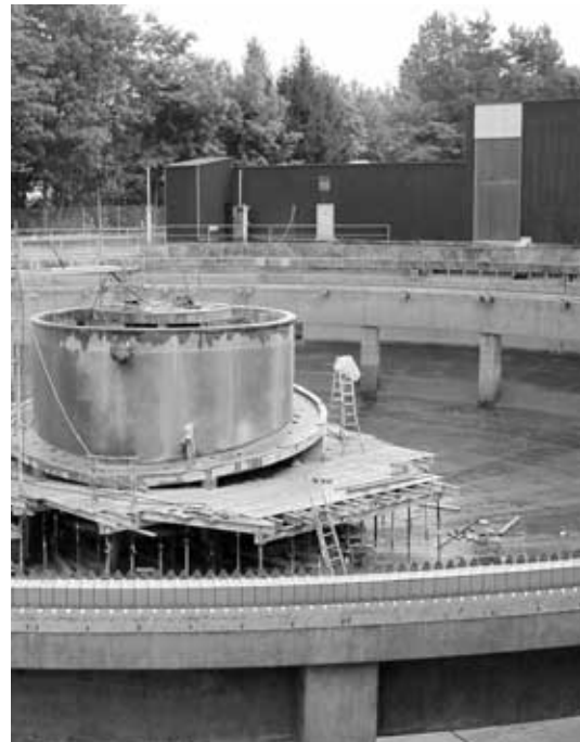
Ein Vorklärbecken wird saniert und an die neuen Bedürfnisse angepasst.
