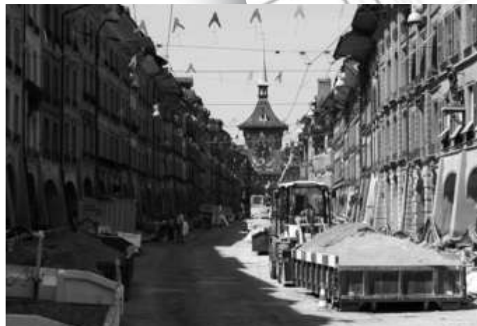
Sanierung durch Stokar+Partner: histo- rische Kramgasse in Bern
