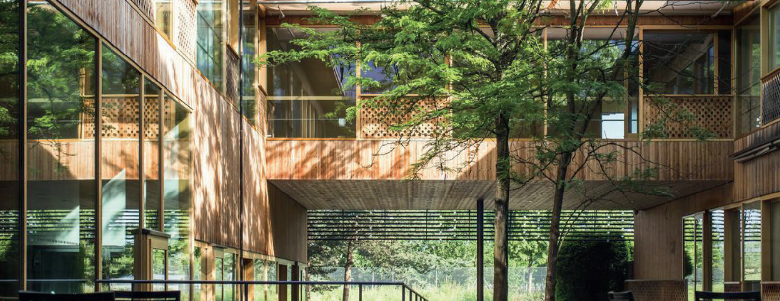
Foto: REHAB Basel
